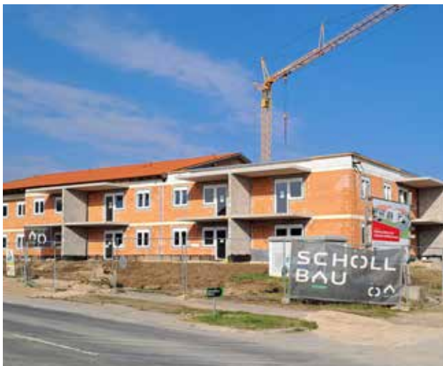
WH 24 Wohnungen BT 1 (10226) gerade in Bau, Fertigstellung 2025
