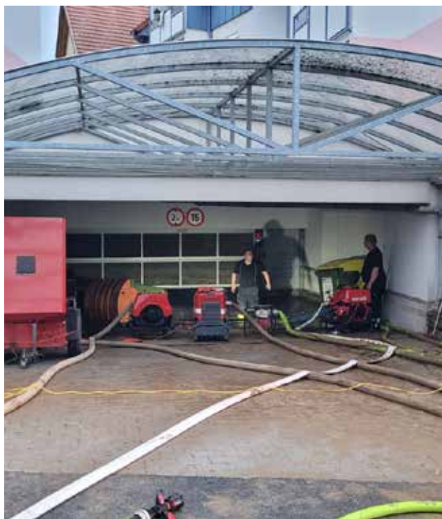
Pumparbeiten in einer Tiefgarage in Baumgarten, bei welcher die Feuerwehr Loipersbach mit zwei Pumpen und sieben Mann unterstützte.
